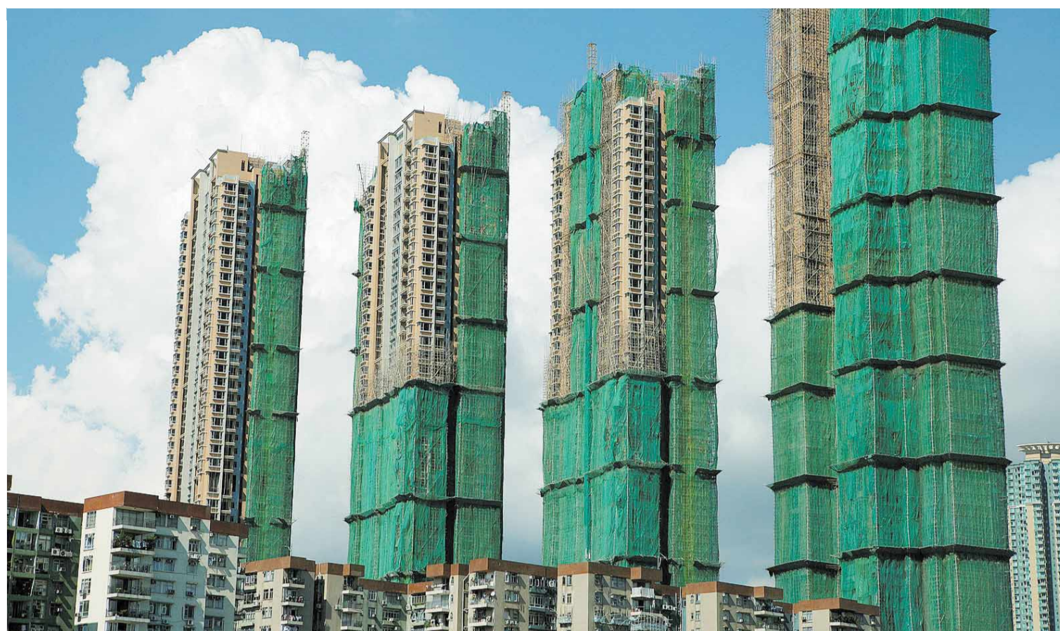
Hochhausbaustelle in Hongkong: In Asien lassen sich wegen der niedrigen Immobilienrenditen nur noch mit Neubauten und Generalsanierungen Gewinne erzielen
