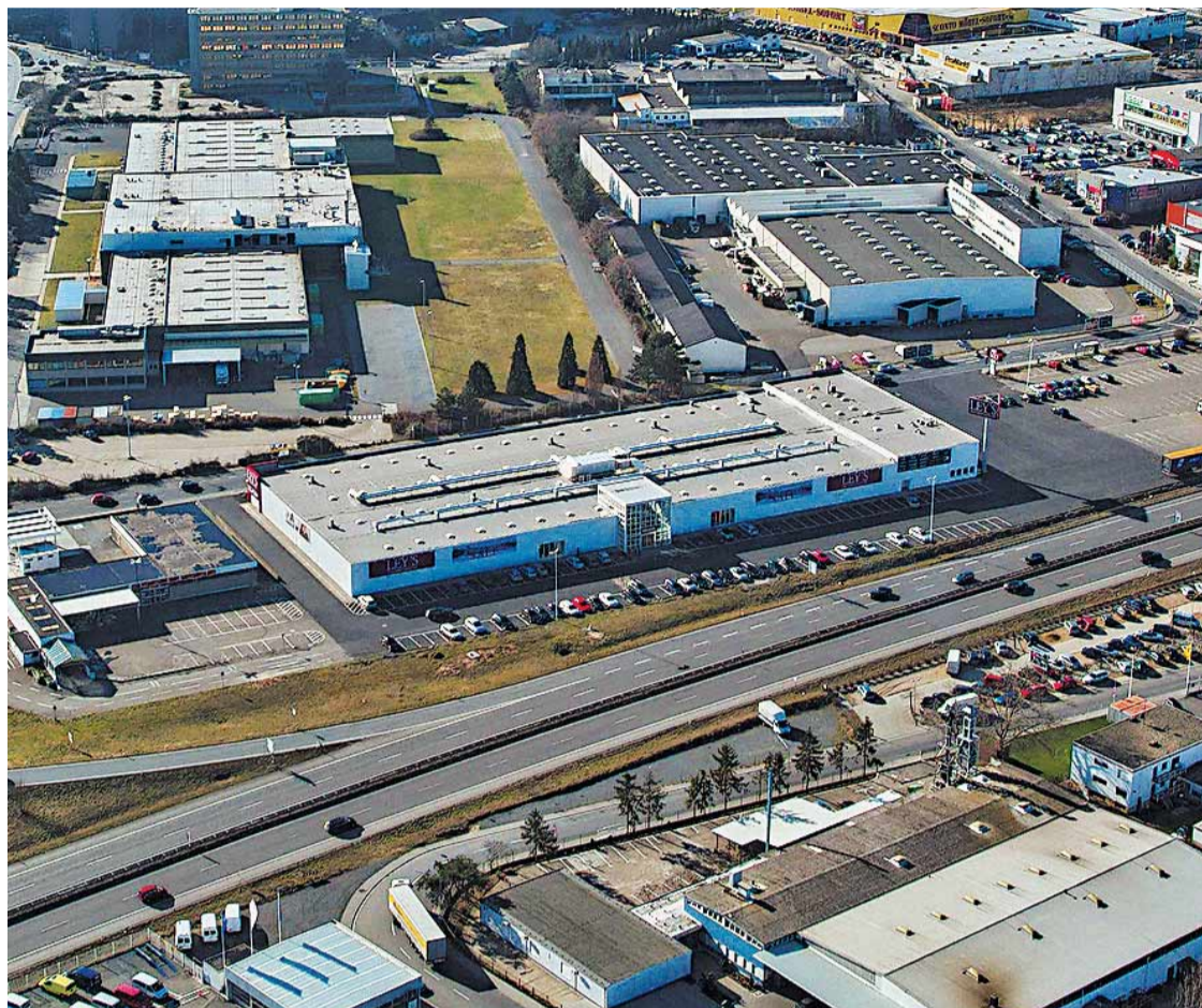
Glamour sieht anders aus: Das Fachmarktzentrum Weiterstadt ist eine eingeschossige, 40 Jahre alte Betonhalle
